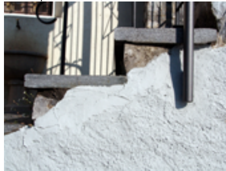
dettaglio rinzafo muro di pietra
