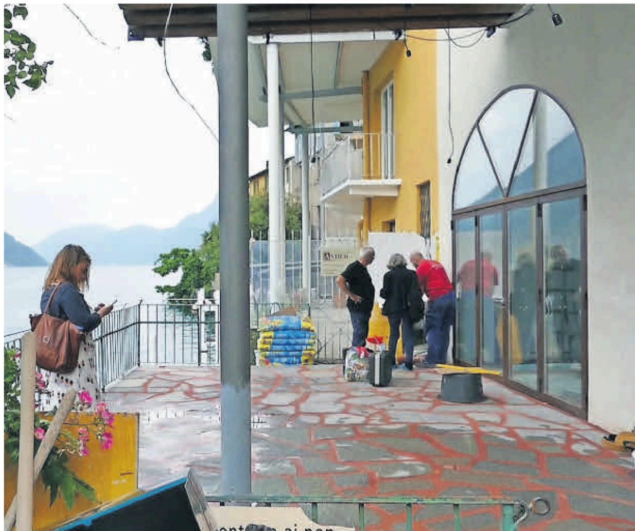
LAVORI IN CORSO Il cantiere in una foto di qualche settimana fa. Sulla terrazza ci saranno i tavolini del bar.
