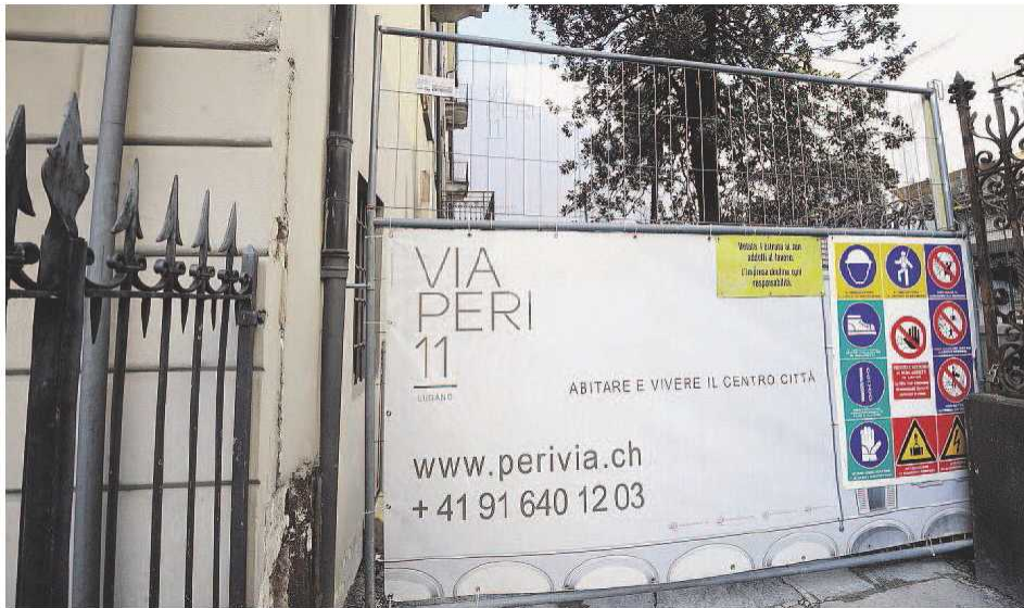
RALLENTAMENTO Per finire di sopraelevare uno degli stabili serve una nuova domanda edilizia. (Foto Demaldi)
